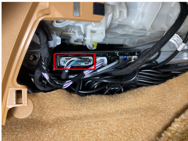
Белый 34 контактный разъем блока телематики (DCM), под центральным тоннелем
